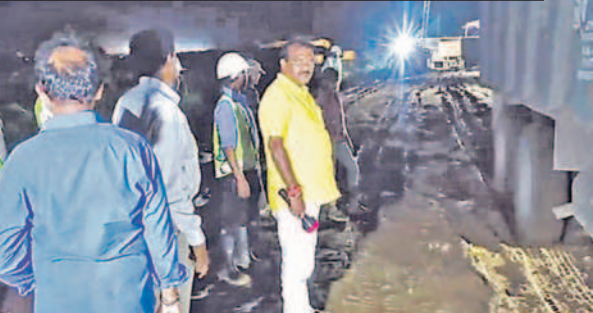
బుడమేరు గండ్లుపూడ్చివేత పనులను పర్యవేక్షిస్తున్న మంత్రి నిమ్మల
